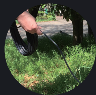
2. ケーブルを敷設
