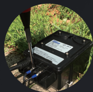
4. ケーブルをトランスに接続
