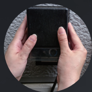
5. トランスを設置 ※地面から30cm以上の高さに設置
